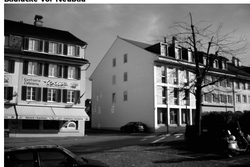
Baulücke vor Neubau
